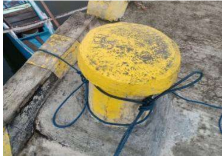
Gambar 4. Bollard yang terdapat di PPI Cempae
