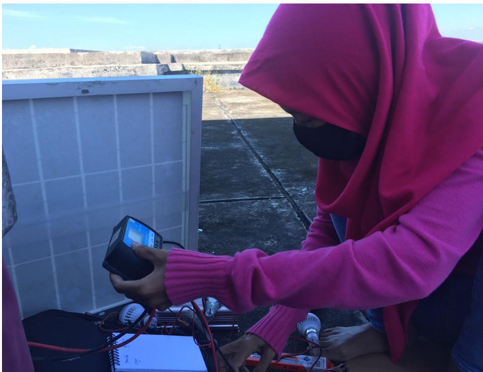
Proses pemasangan rangkaian sebelum melakukan pengisian battery
