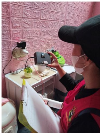
Pemasangan alat sensor DHT22/BME280 berbasis Internet of Things untuk mengukur suhu dan kelembapan
