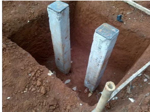
Gambar 6. Fondasi mini pile
