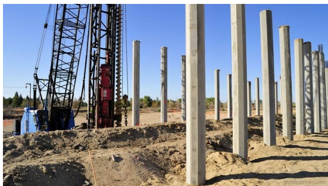
Gambar 4. Fondasi tiang pancang
