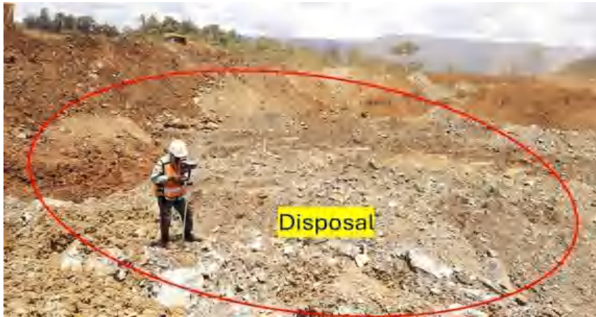
Gambar 17. Pengambilan Data Elevasi pada area Unmined yang akan dijadikan sebagai area Disposal .
