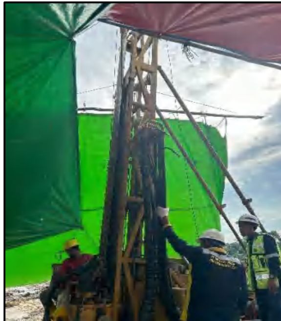
Gambar 14 Pengecekan kondisi mesin pada rig
