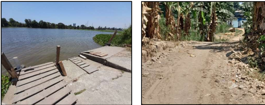
Gambar 2. 3. Kondisi dermaga dan akses jalan menuju titik penyeberangan Sungai Jeneberang
