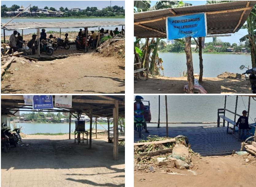
Gambar 2. 5. Sarana & Prasarana Penyeberangan Lokasi 2
