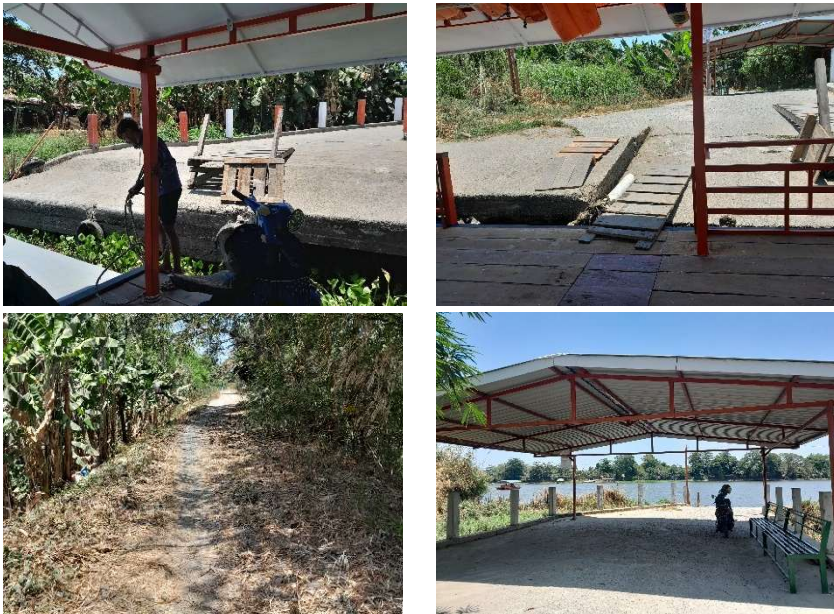
Gambar 2. 7. Sarana & Prasarana Penyeberangan Lokasi 4
