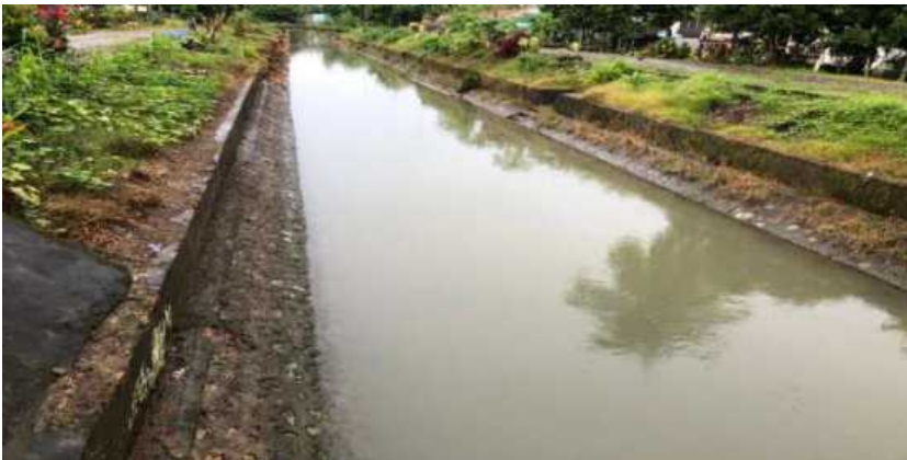
Gambar I.5. Saluran irigasi yang dilapisi pasangan batu
