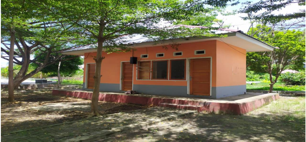
Gambar 2.3. Rumah jaga di lokasi RTH lalong
