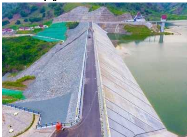
Gambar 3. Bangunan Pelimpah Sumber : UPB Karalloe
