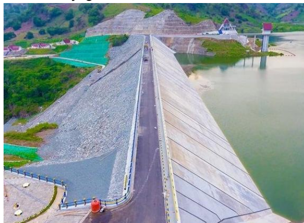
Gambar 3. Bangunan Pelimpah Sumber : UPB Karalloe
