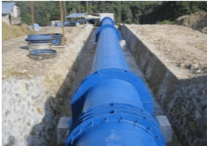
Gambar 5. Pipa Pesat Sumber : PLTA Malea
