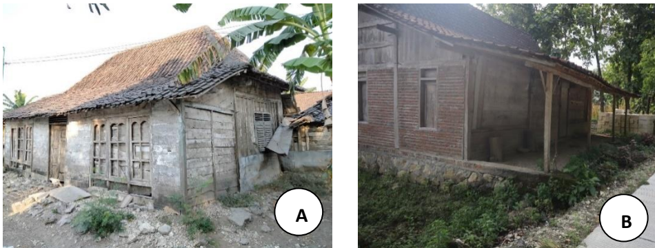
Gambar 3. A Bangunan lama dan B Bangunan Baru Sumber: Penelitian lapangan, 2024
