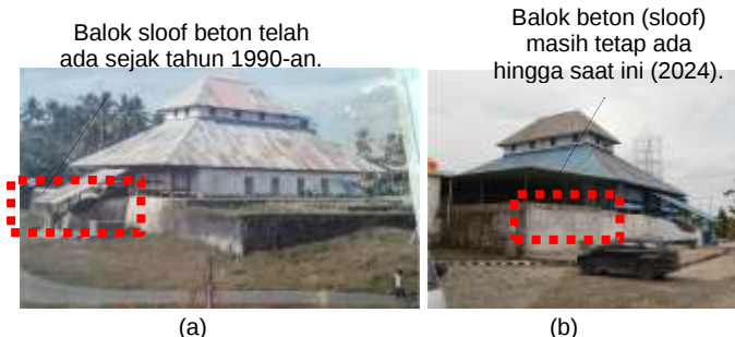
Gambar 2. 6 (a) Balok ikat beton bertulang pada tampak depan sisi timur-selatan MAKB pada tahun 1990-an (Sumber: Erwiansyah, 2024). (b) Hingga tahun 2024, balok sloof bertulang tersebut masih berada pada posisinya.
