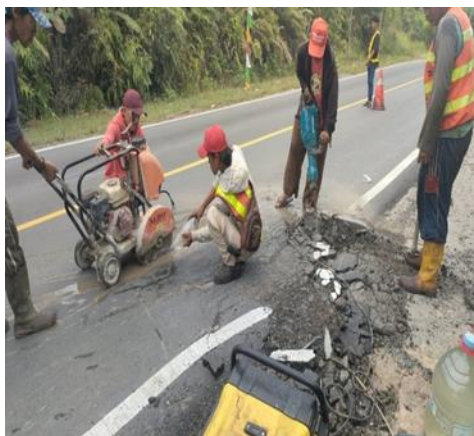
Gambar 1. 1 Proses pengelupasan jalan yang rusak
