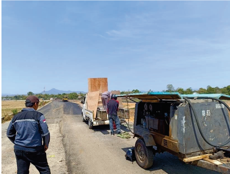
Gambar 2.8. Proses sand blasting di luar laboratorium
