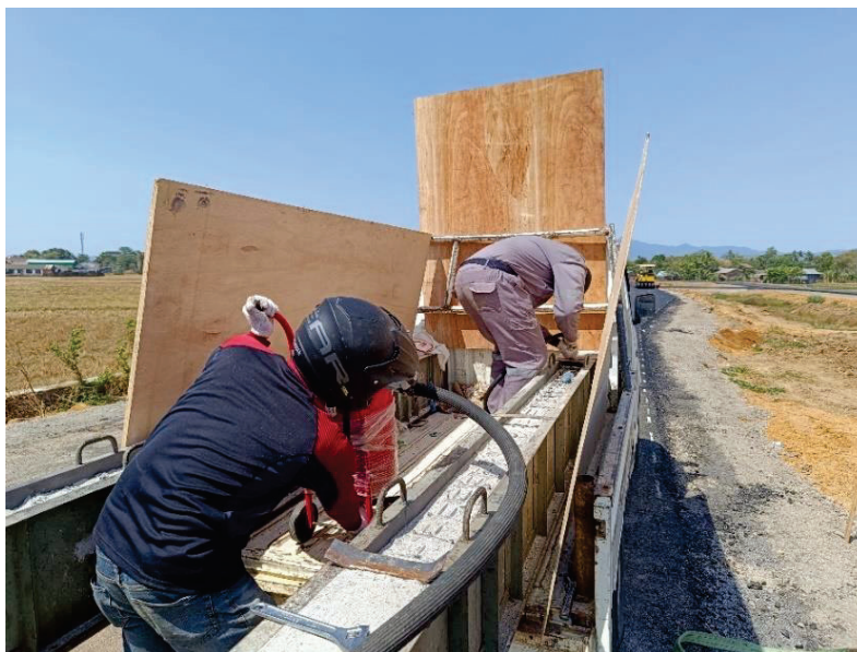
Gambar 2.9. Close up pengerjaan sand blasting pada benda uji
