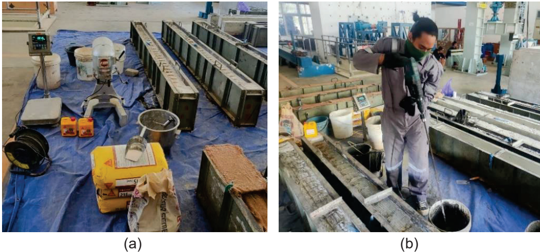
Gambar 2.11. Pembuatan pasta grouting : (a) bahan dan alat grouting (b) pencampuran bahan grouting
