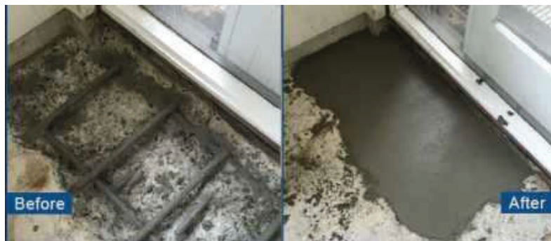
Gambar 1.13. Perbaikan dan finishing dengan material grouting (the constructor, 2018)
