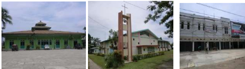
Gambar 2. 25 Kondisi bangunan tahun 2013
