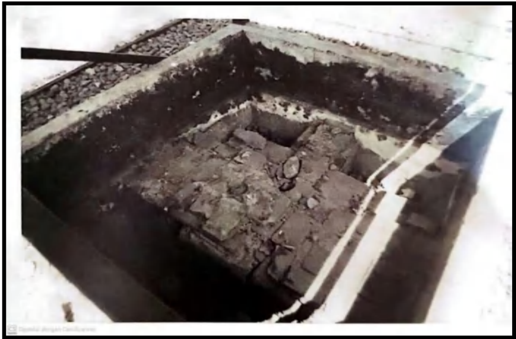
Foto 2. 2 Galian di sisi Gereja Kristen di tengah-tengah benteng, menunjukkan konstruksi asli fondasi Benteng Jumpandang.
