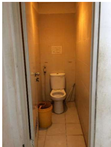
Gambar 40. Kondisi Toilet D 1.2
