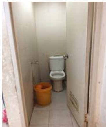
Gambar 37. Kondis Toilet D 1.1
