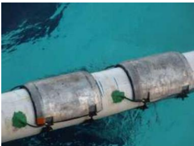
Gambar 1.9 Proteksi katodik pada pipa bawah laut
