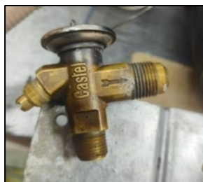
Gambar 7 Katup Ekspansi
