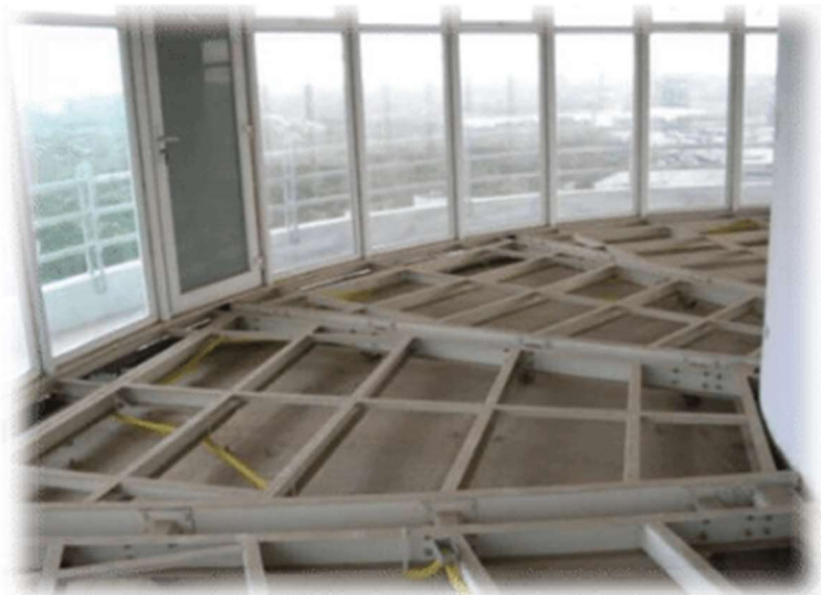
Gambar 16. Rangka Platform yang berputar di atas plat beton Sumber: academia.edu
