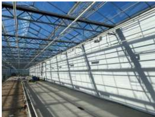
Gambar. 23 Struktur Baja Ameerlaan-sosef
