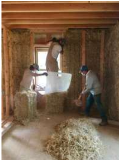
Gambar. 39 Sistem Dinding Bal Jerami Pada Blue Dot Farm
