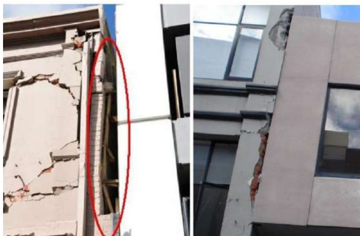
Gambar 6. Dampak Kerusakan Akibat Pounding Sumber: (Cole dkk., 2012)
