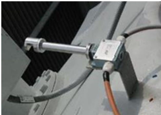
Gambar 24. Detektor Pencegah Kebakaran (Sumber: PLN, 2024)
