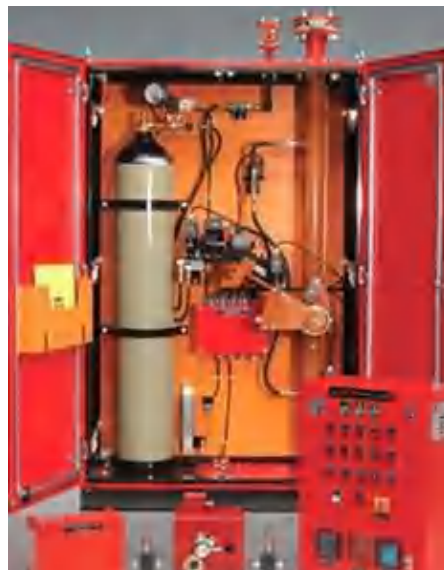
Gambar 26. Kabinet Sistem Pencegah Kebakaran (Sumber: PLN, 2024)
