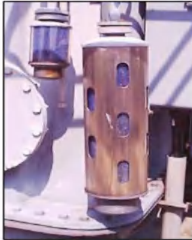
Gambar 12. Konstruksi Konservator dengan Rubber Bag (Sumber: PLN, 2024)
