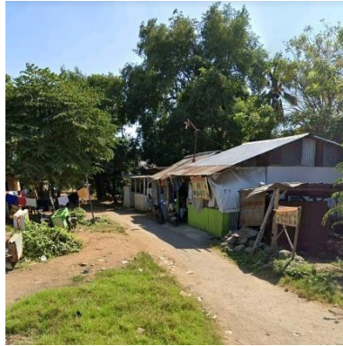
Gambar 2. 2 Kondisi Bangunan di Kelurahan Tanjung Merdeka
