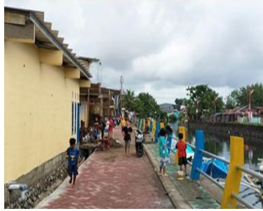
Gambar 2. 13 Kondisi Drainase Lingkungan di Kelurahan Bontorannu
