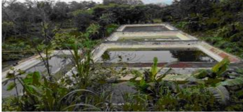
Gambar 2. 4 Bak Penampungan, Sumur, dan Kolam Lindi
