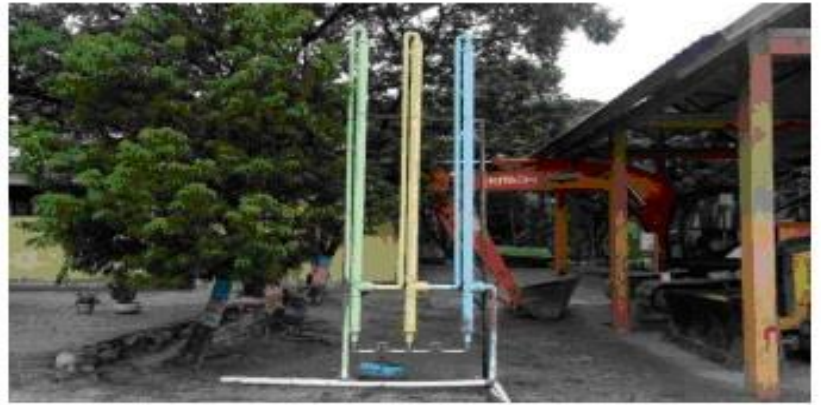
Gambar 2. 5 Pipa Penangkap Metana
