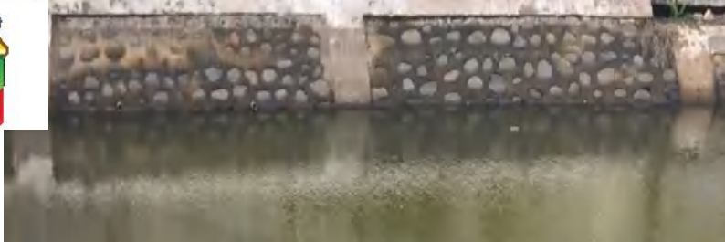
Gambar 1 Pekerjaan Batu Menggunakan Mortar
