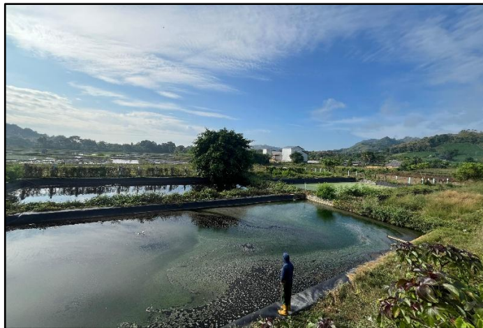
Gambar 2.4 Instalasi Pengolahan Air Lindi Patommo
