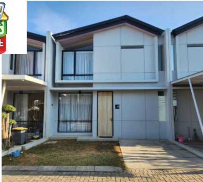
Gambar 25: Tampak Hunian Tipe 3 (Klaster Rolling Hills ). Sumber: Survey Lapangan (Oktober 2024)
