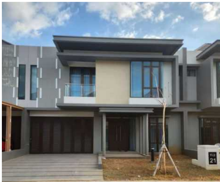
Gambar 19: Tampak Hunian Tipe Diamond (Klaster Treasure Island ) Sumber: Survey Lapangan (Oktober 2024)
