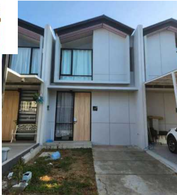
Gambar 21: Tampak Hunian Tipe 1 (Klaster Rolling Hills ). Sumber: Survey Lapangan (Oktober 2024)
