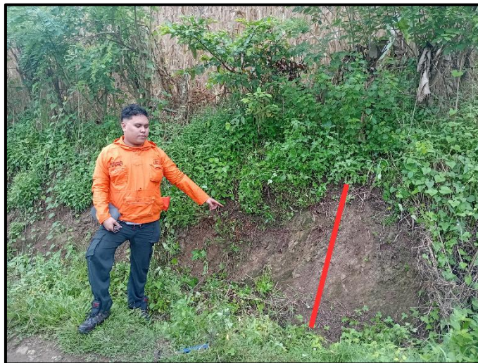
Gambar 2. 7 Residual soil pada litologi batulempung dengan warna coklat dengan tebal kurang lebih 1 meter difoto ke arah N38°E
