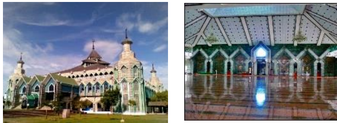
Gambar 18 : (kiri) Tampak masjid, (kanan) ruang salat Sumber : arsy.co.id/ simas.kemenag.go.id
