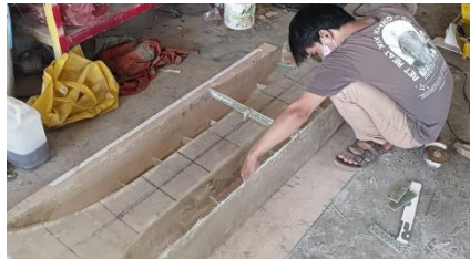
Gambar 35. Proses Pemasangan Gading-gading
