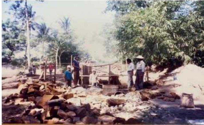
Gambar 6. Potret proses rekonstruksi benteng. (Sumber: Arsip Pribadi Suriadi Mappangara.)
