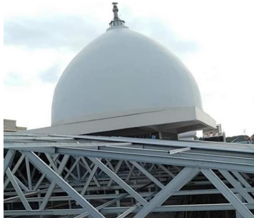
Gambar 2. Kondisi kubah Masjid Ittifaqul Jamaah dalam tahap renovasi pada tahun 2019
