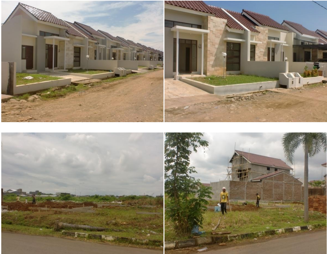
Gambar Lampiran 9. Foto proses pembangunan Perumahan Anging Mammiri
