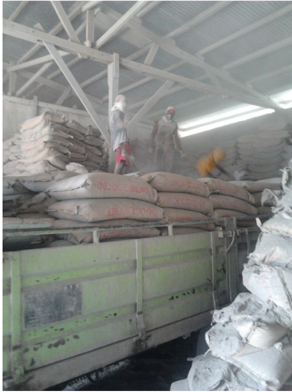
Pekerja menurunkan semen dari truk pengangkut
