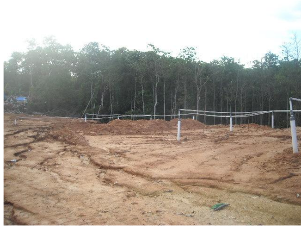
Gambar 1. Pengolahan gas metan pada zona bekas pembuangan sampah
