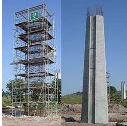
Gambar 3 Beton Bertulang Pada Kolom Bangunan
