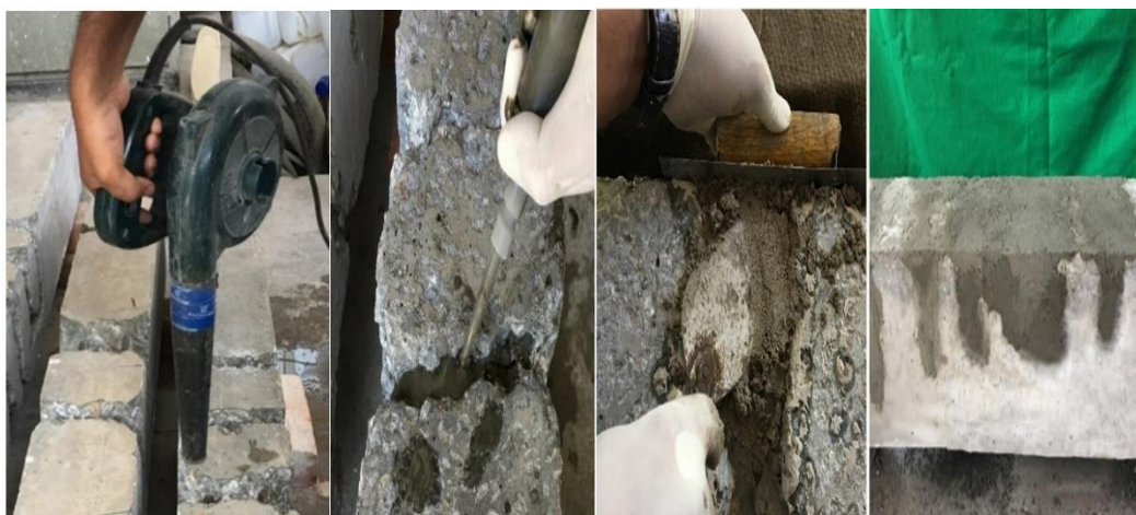
Gambar 1. Proses perbaikan mortar geopolimer pada balok
