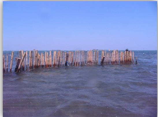
APO dengan metode tancap satu persatu (APO yang digunakan hingga akhir penelitian)
