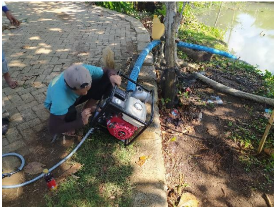
Pemasangan dan pengujian pompa air berbahan bakar gas
