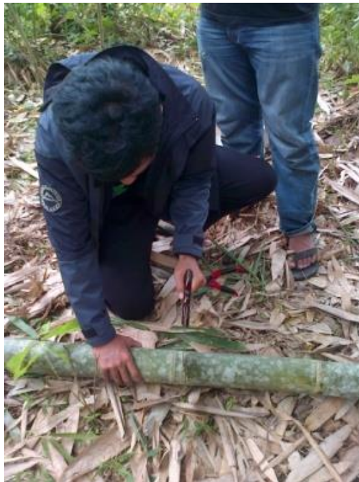
Pemotongan bambu untuk menghilangkan buku
