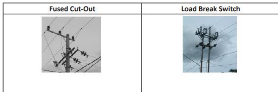
Gambar 2 10 Contoh letak pemasangan FCO dan LBS
