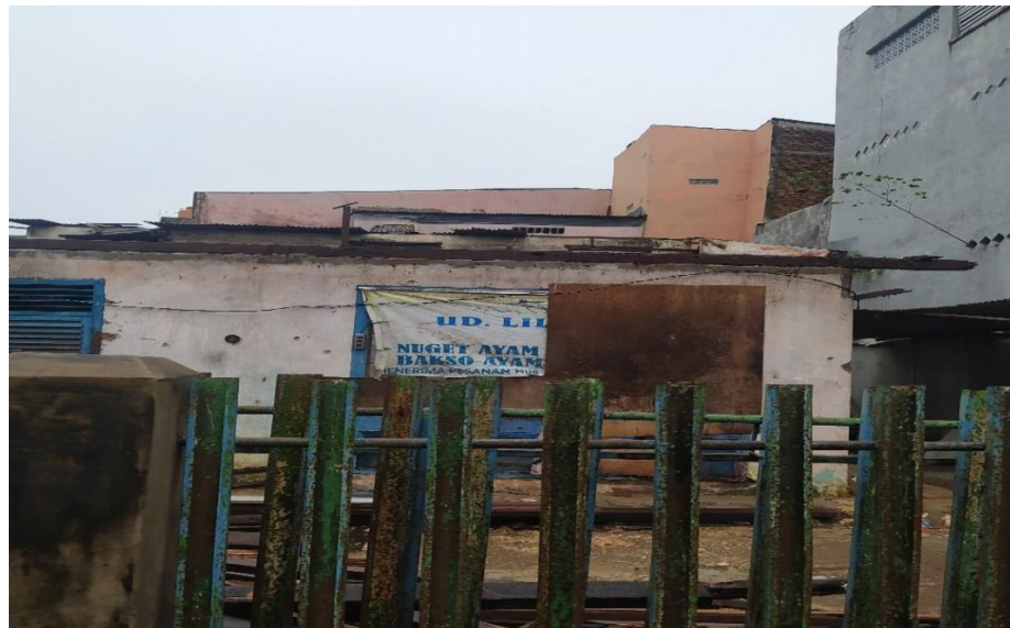
Gambar 2. Kondisi bangunan bekas rumah tangga produksi bahan pangan beku ( UD. Lilafood) di Desa Ma'rumpa yang sedang mengalami renovasi.
