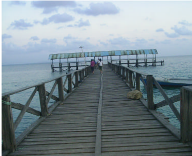
Foto 3. Kondisi Dermaga di Kecamatan Liukang Tupabbiring
