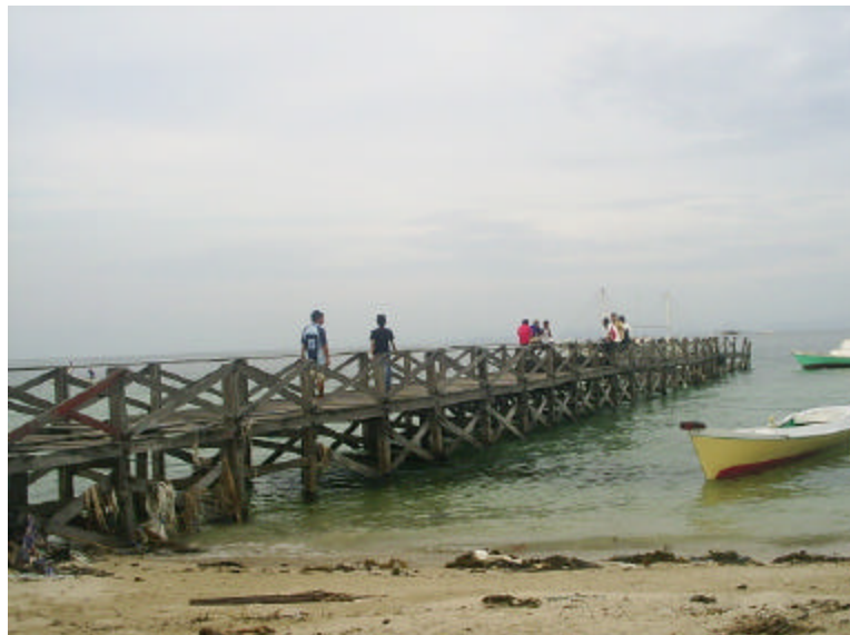
Foto 4. Kondisi Dermaga di Kecamatan Liukang Tupabbiring
