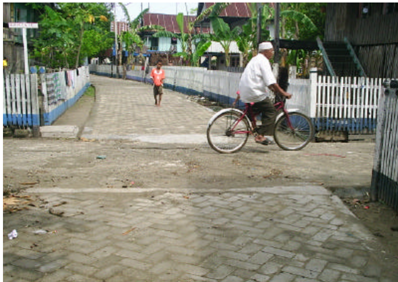
Foto 6. Kondisi Eksisting Jalan Desa dengan Paving Blok
