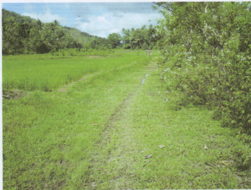
Prasarana jalan di Lappaarenne Desa Saotanre pelaksanaan Ta.2004
