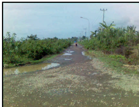
Kondisi ruas jalan utama blok AE (pos pengamatan kelima)
