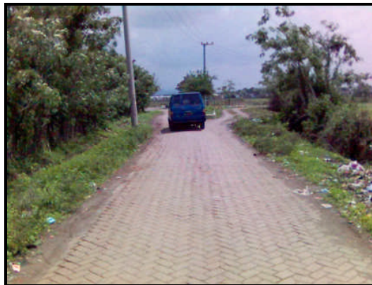
Kondisi pintu timur BTP (pos pengamatan ketiga)
