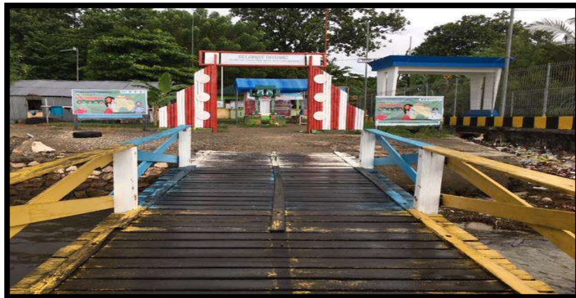
Gambar 20. Kondisi Dermaga Pulau Sabutung
