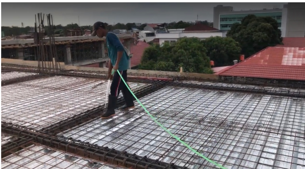
Pembersihan lokasi pengecoran
