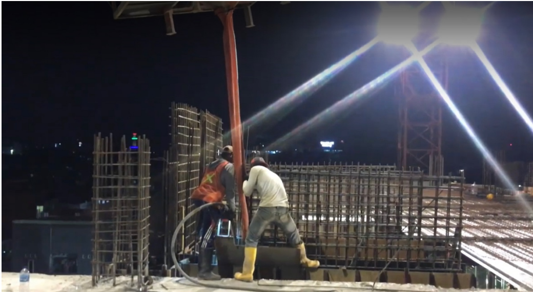
Penggunaan Alat Vibrator (mesin getar dalam)
